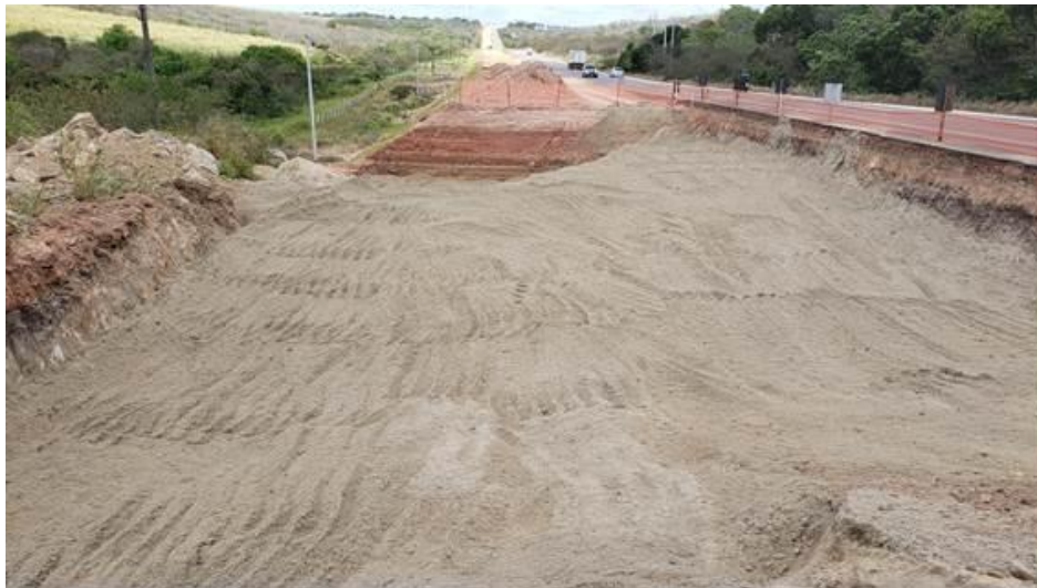
Figura 3.15 – Colchão drenante de areia executado junto a trecho com ocorrência de material de 3ª categoria nas obras de duplicação da BR-304/RN. (Fonte: Próprio autor).
