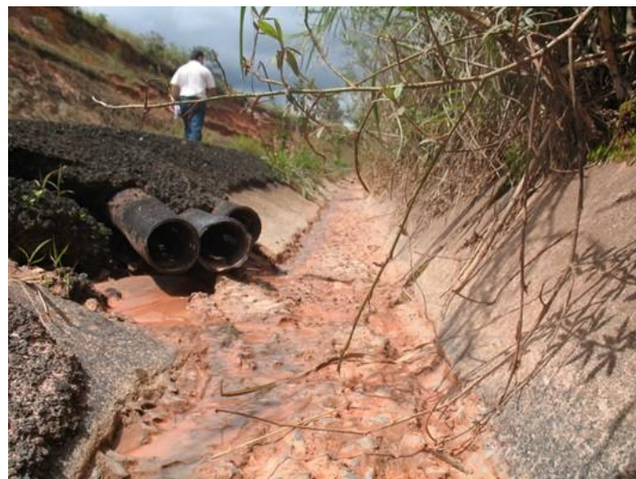
Figura 2.21 – Saída de dreno em sarjeta de corte junta da BR-354/MG (Fonte: próprio autor).
