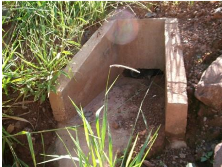
Figura 2.20 – Boca de saída de dreno instalada nas obras de duplicação da BR-304/RN (Fonte: próprio autor).
