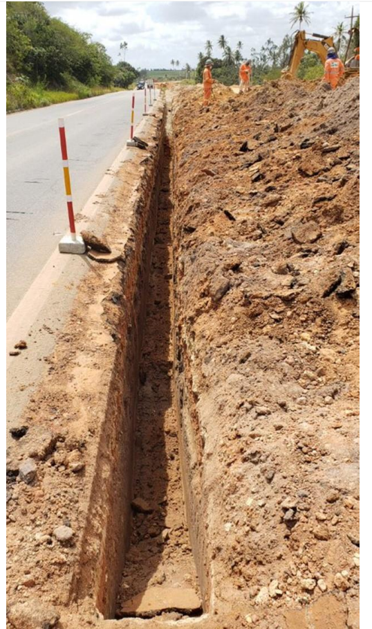
Figura 3.6 – Implantação de dreno tipo DPS-02 nas obras de duplicação da BR-304/RN. (Fonte: Próprio autor).
