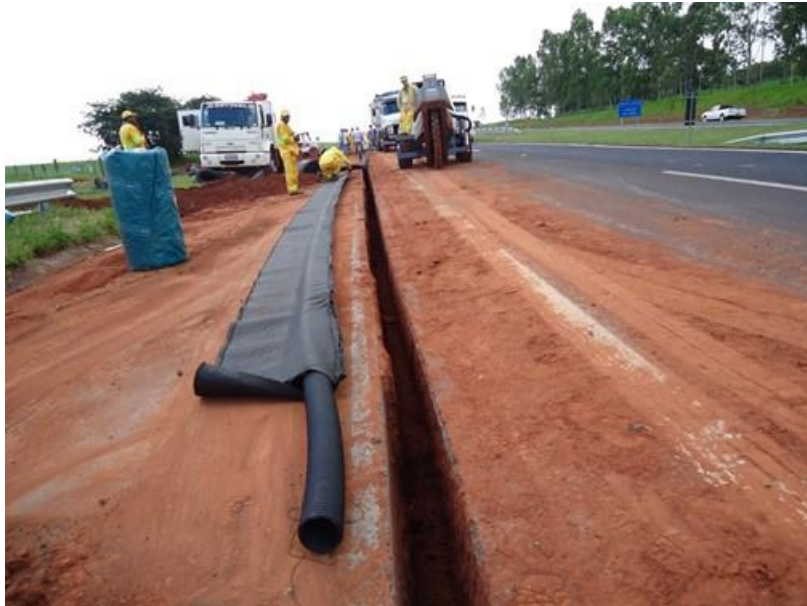
Figura 3.9 – MacDrain TD aplicado na Rodovia Transbrasiliana, Lins/SP. (Fonte: MACCAFERRI / Concessionária Via Rondon).
