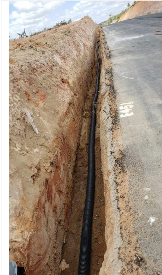
Figura 3.5 – Implantação de dreno tipo DPS-02 nas obras de duplicação da BR-304/RN. (Fonte: Próprio autor).
