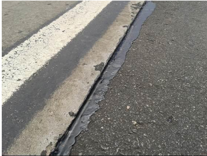
Figura 2.1 – Junta acostamento-pista, sendo pista em CCP e acostamento em CA (Fonte: próprio autor).
