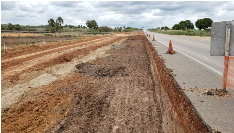
Figura 3.17 – Colchão drenante de areia encontrado sob a plataforma existente na BR-304/RN. (Fonte: Próprio autor).
