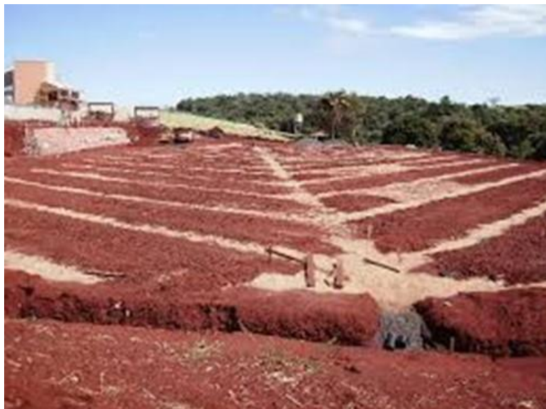
Figura 3.14 – Dreno espinha de peixe instalado em campo de futebol.
