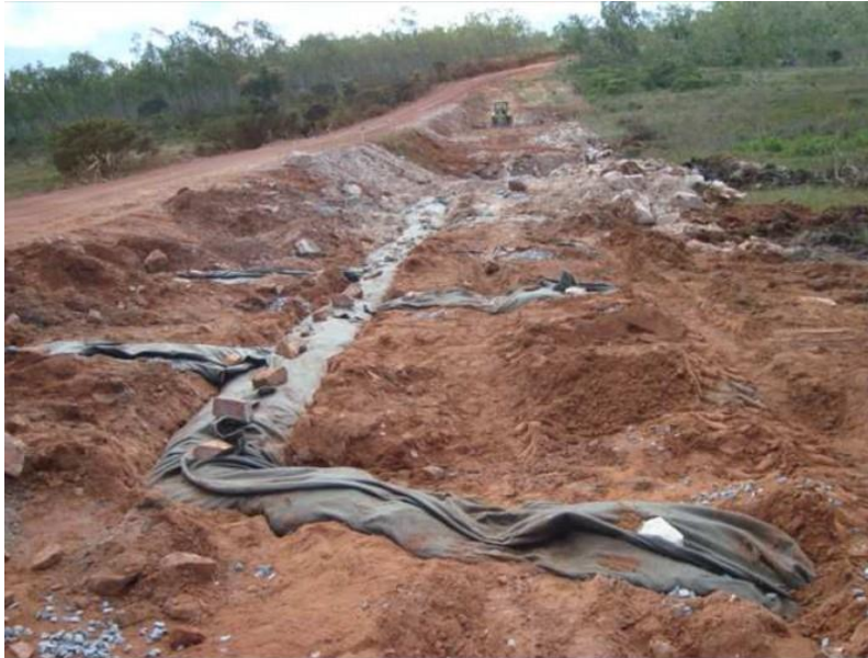
Figura 3.13 – Dreno espinha de peixe instalado em rodovia de Minas Gerais. (Fonte: Notas de aula, JABÔR).
