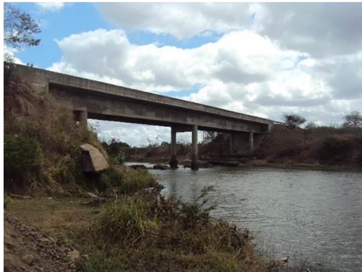
Figura 3.2 – Ponte sobre o Rio Choró na BR-116/CE (Fonte: próprio autor).
