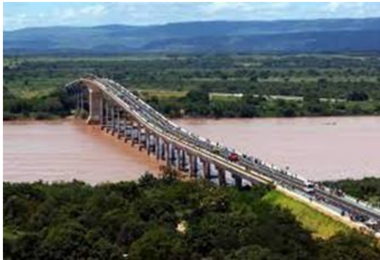
Figura 3.3 – Ponte sobre o Rio São Francisco no traçado da BR-116 no estado da Bahia.
