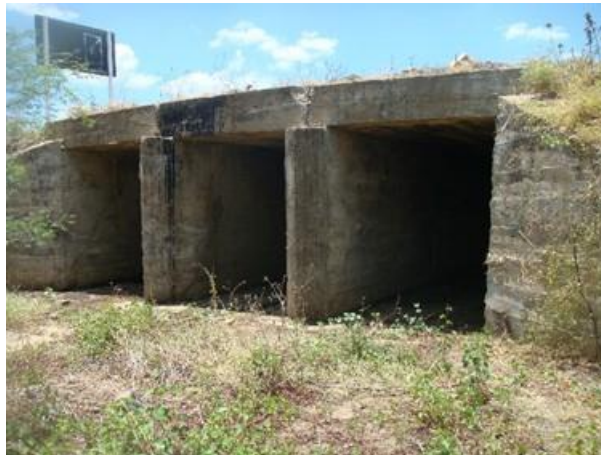
Figura 2.12 B – BTCC instalado em rodovia. (Fonte: próprio autor).
