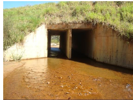
Figura 2.11 B – BDCC instalado em rodovia. (Fonte: próprio autor).
