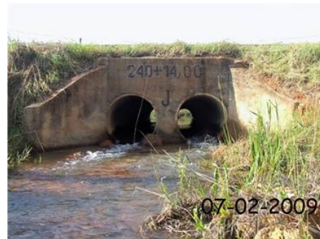
Figura 2.5 B – BDTC instalado em rodovia (Fonte: próprio autor).
