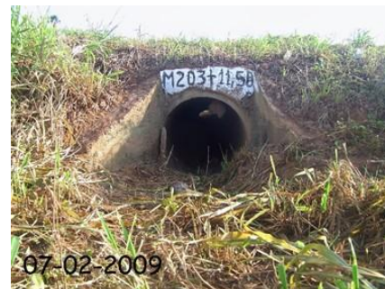
Figura 2.4 B – BSTC instalado em rodovia (Fonte: próprio autor).
