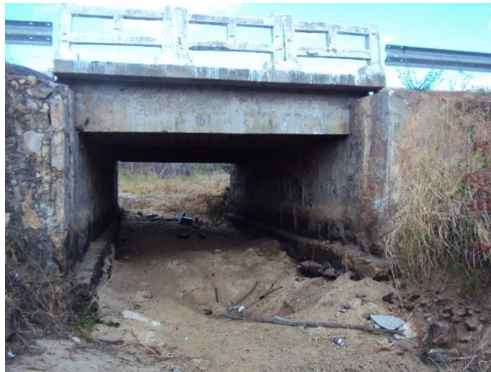
Figura 3.1 – Pontilhão instalado na BR-116/CE (Fonte: próprio autor).
