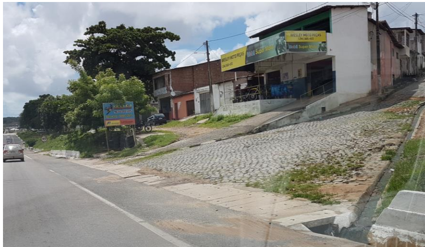
Figura 3.11 – Transposição de segmento de sarjeta tipo TSS-02 implantado na BR-226/RN. (Fonte: Próprio autor).
