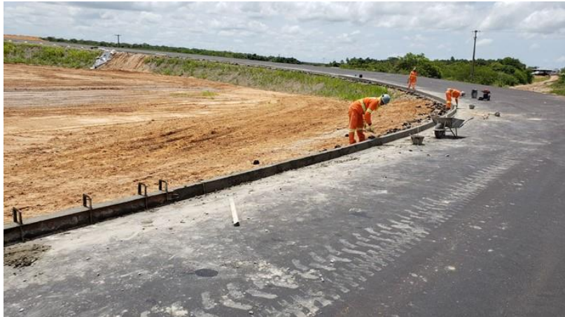
Figura 3.7 – Meio-fio tipo MFC-05 em execução nas obras de duplicação da BR-304/RN. (Fonte: Próprio autor).
