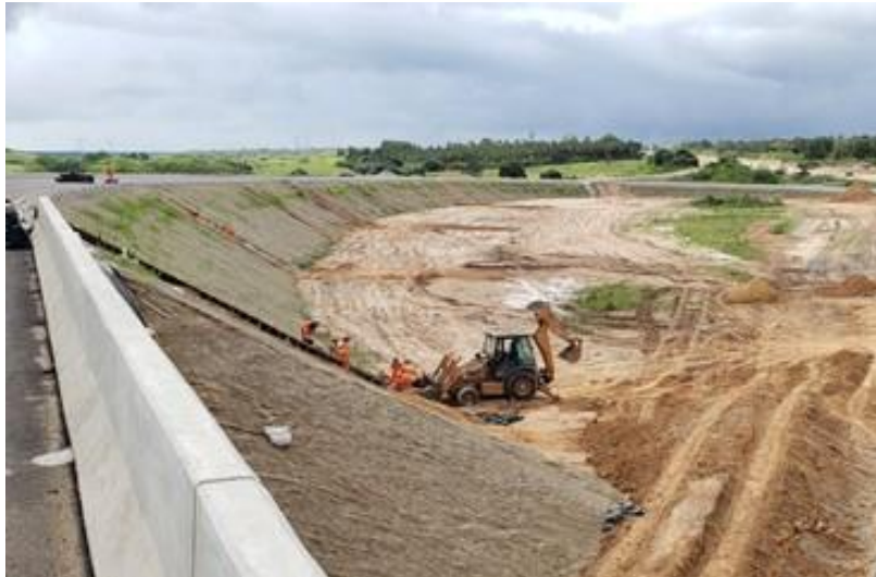
Figura 3.17 – Detalhe de descida d'água em execução na BR-304/RN. (Fonte: Próprio autor).
