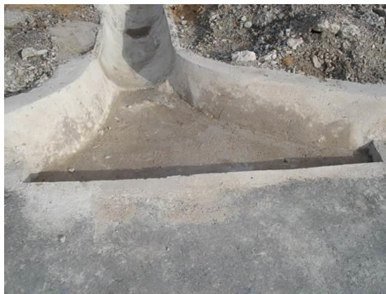
Figura 3.14 – Detalhe de entrada d'água implantado na BR-101/RN. (Fonte: Próprio autor).
