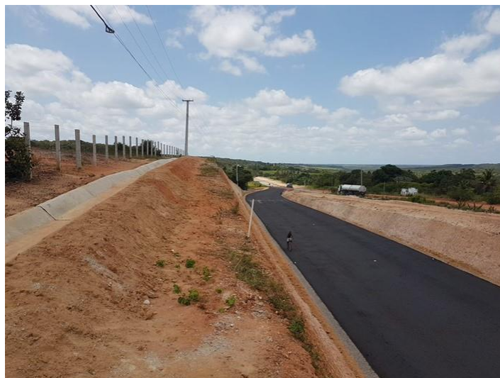
Figura 3.1 – Valeta trapezoidal de corte executada nas obras de duplicação da BR-304/RN. (Fonte: Próprio autor).
