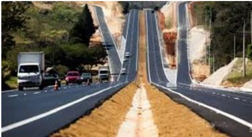
Figura 3.9 – Sarjeta de canteiro central de formato triangular.
