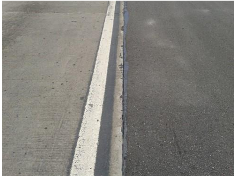
Figura 2.3 – Trecho da BR-101/RN onde o acostamento foi executado com CA e as faixas de rolamento em CCP. (Fonte: próprio autor).
