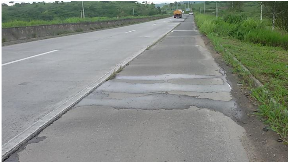
Figura 2.4 – Trecho da BR-232/PE onde o acostamento foi executado com CA e as faixas de rolamento em CCP. (Fonte: próprio autor).
