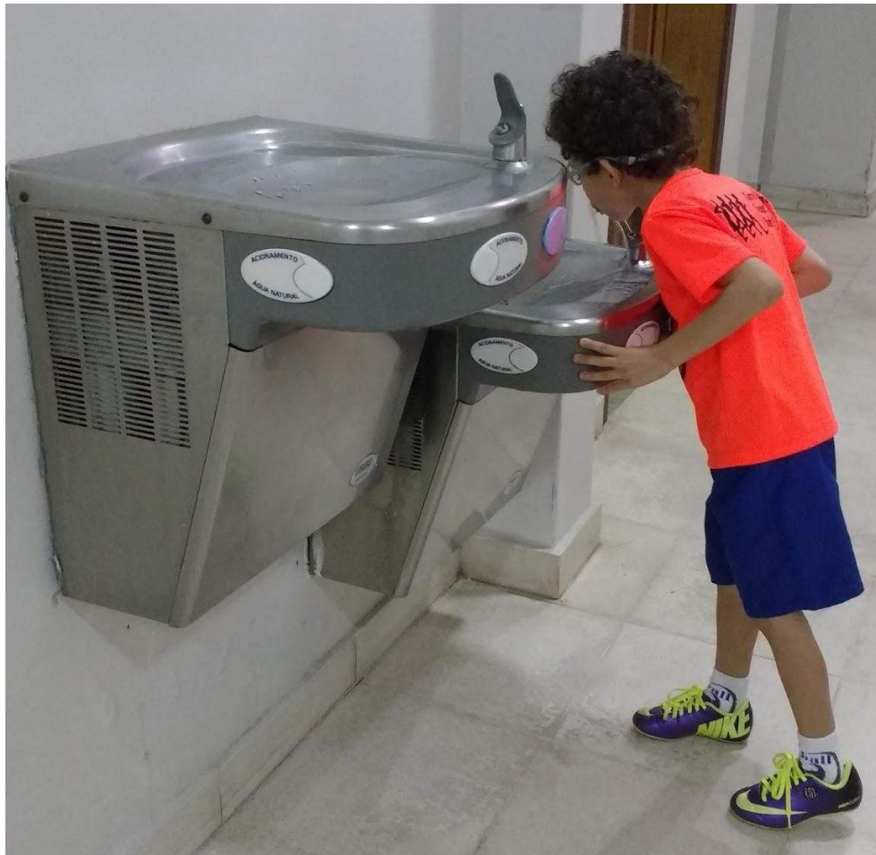
Fig. 30: Bebedouro acessível com bicas a 0,85 e a 1,10 m do piso acabado. Fonte da imagem: Rafael Campos.
