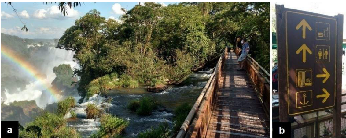
Fig. 21: a) passarela suspensa sobre uma das cachoeiras do parque das Cataratas do Iguazu (Argentina). A passarela possui material condizente com a paisagem do local, com guarda-corpo, corrimão e piso antiderrapante. A largura do passeio permite que duas pessoas passem lado a lado ou uma pessoa em cadeira de rodas; b) Na imagem vemos uma placa de sinalização do mesmo parque, que demonstra a presença de atividades através de pictogramas facilmente reconhecidos.
