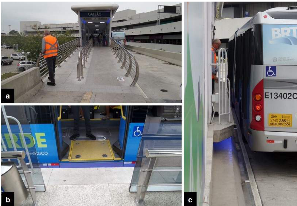
Fig. 9: Acesso ao BRT no Galeão. a) rampa de acesso à estação; b) piso de embarque no mesmo nível do ônibus; c) detalhe do piso que avança sobre o vão entre plataforma e o ônibus. Fonte: Acervo pessoal de Rodrigo Abreu de Freitas Machado.
