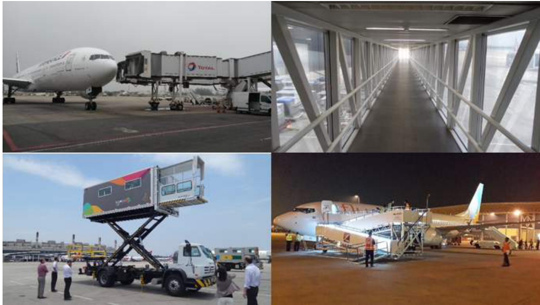
Fig. 13: Exemplos de dispositivos para acesso à aeronave. (a) Ponte de Embarque; (b) Vista interna da ponte de embarque; (c) Ambulift; (d) Rampa móvel. Fonte das imagens: (a) (b) (c) - acervo pessoal de Rodrigo Machado. (d) https://commons.wikimedia.org/wiki/File:Passenger_Boarding_Ramps.jpg (CC SA 4.0)
